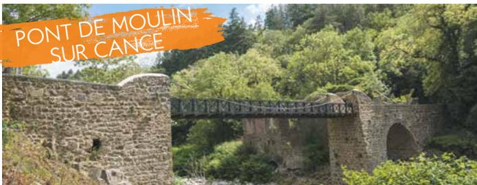
C'est l'inventeur annonéen **Marc Seguin** qui a inventé la technique des **ponts suspendus à câbles de fil de fer**. Ce pont est l'un des derniers ouvrages présents mettant en valeur son ingéniosité.
